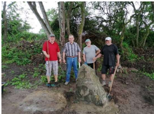
Fotos: Ehrenamtliche beim Setzen eines Natursteins und beim Anlegen eines Schotterbettes für die Gehwegplatten.
