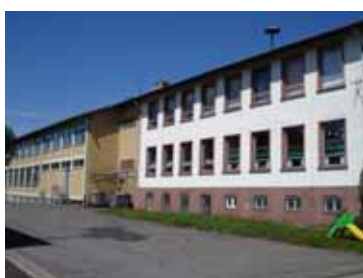
Ehemalige Grundschule Kutzhof
