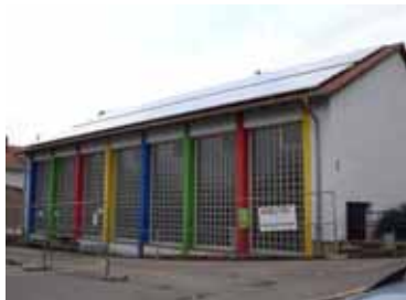
Turnhalle Grundschule Heusweiler-Dilsburg
