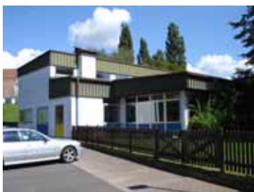
Katholischer Kindergarten Eiweiler
