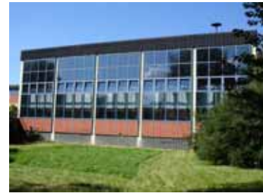
Turnhalle Grundschule Eiweiler
