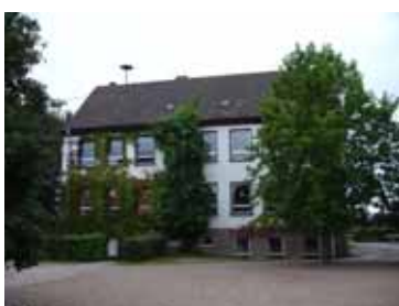
Ehemalige Grundschule Obersalbach-Kurhof
