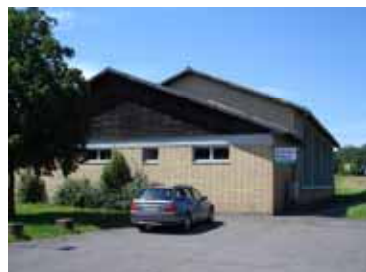
St. Barbarahalle Kutzhof
