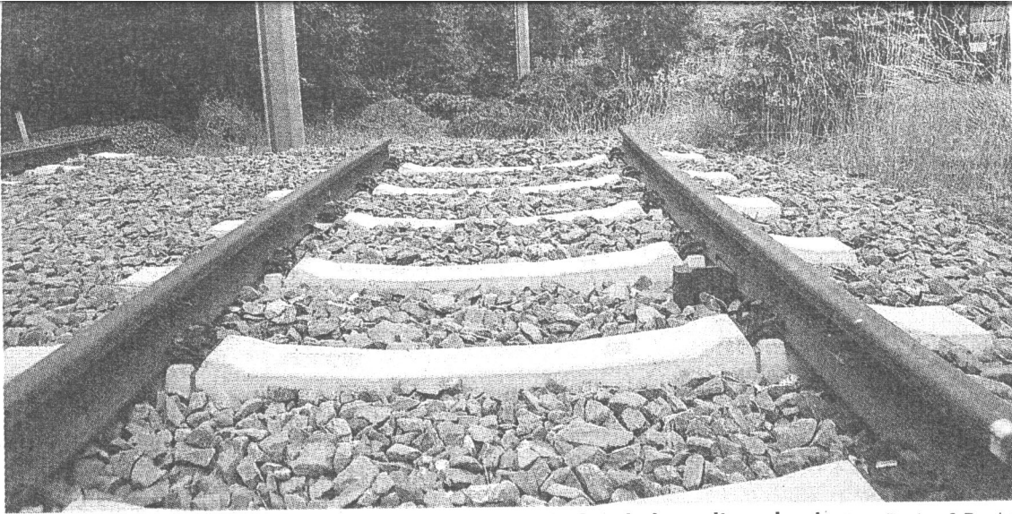
Noch ist hier in Etzenhofen Schluss. Ab 2009 wird die Saarbahn weitergebaut. Foto: Becker & Bredel
